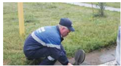
Приборное обследование газопровода
