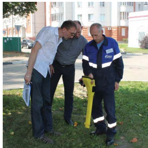
Приборное обследование газопровода выполняет Николай Владимиров, монтер по защите подземных трубопроводов от коррозии службы защиты от коррозии филиала в г. Рассказово
