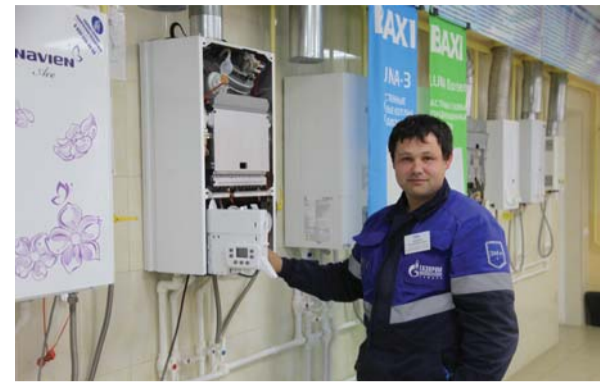
Слесарь филиала службы внутридомового газового оборудования АО «Газпром газораспределение Тамбов» в г. Тамбове Владимир Федосеев выполняет практическое задание
