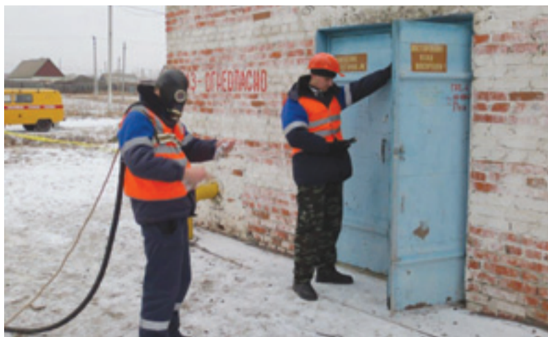
Внеплановый контрольно-тренировочный вызов проводят специалисты Сосновского газового участка филиала ОАО «Газпром газораспределение Тамбов» в г. Моршанске
