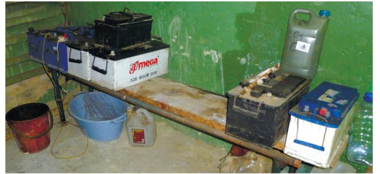
Зарядка и хранение свинцовых аккумуляторов на производственной базе на ул. Киквидзе в непригодном для этого помещении
