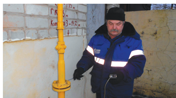
Слесарь аварийно-диспетчерской службы филиала ОАО «Газпром газораспределение Тамбов» в г. Уварово Николай Збродов проводит проверку газового стояка
