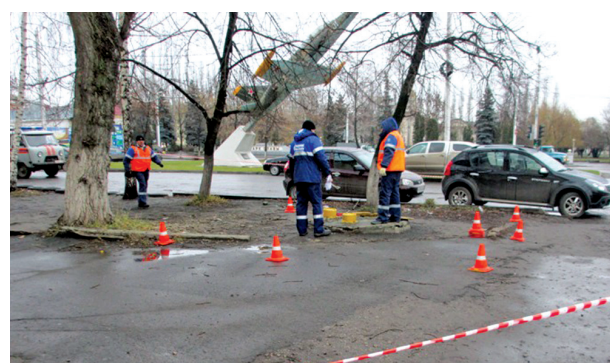
Мастер аварийно-диспетчерской службы Дмитрий Сальников, слесарь Александр Середин, слесарь Роман Гаврилов филиала ОАО «Газпром газораспределение Тамбов» в п. Коммунар отрабатывают контрольно-тренировочный вызов по локализации и ликвидации аварийной ситуации на газопроводе
