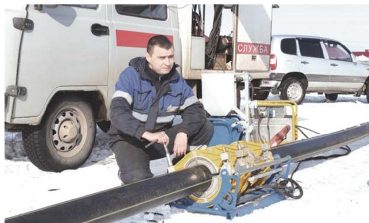
Андрей Нахватов, оператор машин контактной сварки РСУ филиала «Рассказово-межрайгаз» ОАО «Тамбовоблгаз» производит монтаж полиэтиленовых труб для газификации микрорайона «Гвардейский»
