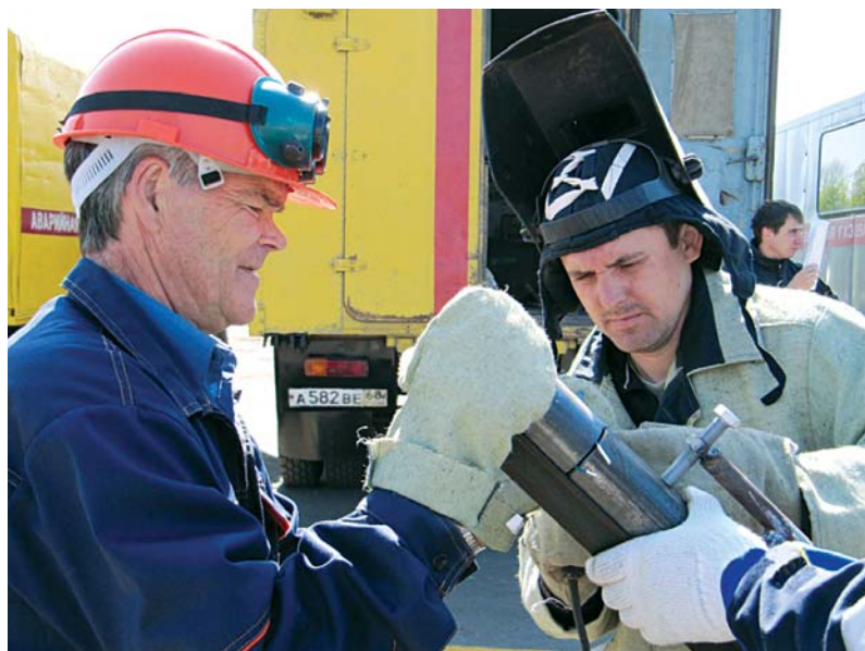
Электрогазосварщик – Михаил Лутовинов и слесарь Юрий Башкатов из филиала «Уварово-межрайгаз» проводят подготовительные работы на первом этапе конкурса
