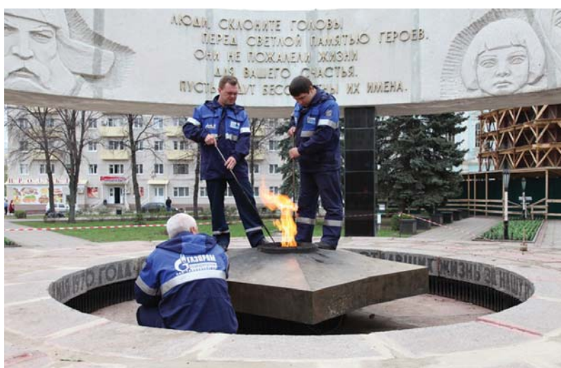
Слесари Александр Терехов, Павел Панкратов и мастер смены АДС Николай Суворин прочищают форсунки газовых горелок и регулируют пламя вечно огня
