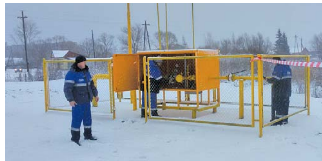
Мастер АДС Роман Пустовалов, слесари аварийно-восстановительных работ Владимир Бальбин и Алексей Тимофеев филиала АО «Газпром газораспределение Тамбов» в г. Рассказово отрабатывают учебно-тренировочный вызов на тему: «Повреждение надземного газопровода»
