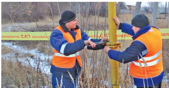
Слесари по эксплуатации и ремонту газового оборудования Умётского газового участка филиала АО «Газпром газораспределение Тамбов» в г. Кирсанове Юрий Ширинов (слева) и Дмитрий Кравчук отрабатывают контрольно-тренировочный вызов
