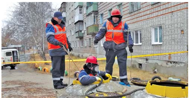
Отработка действий по позициям Плана локализации и ликвидации аварийных ситуаций на сетях газораспределения аварийно-диспетчерской службой филиала АО «Газпром газораспределение Тамбов» в г. Котовске. Слева направо: водитель Анатолий Климов, слесарь аварийно-восстановительных работ Павел Пахомов (спускается в газовый колодец), слесарь аварийно-восстановительных работ Юрий Ерохин
