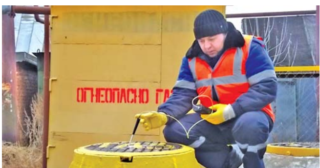
Слесарь аварийно-восстановительных работ Павел Пахомов при проведении учебно-тренировочного вызова, производит замер концентрации газозоудной смеси в газовом колодце
