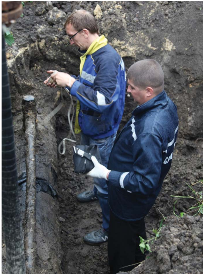
Монитор по защите подземных трубопроводов от коррозии Владимир Четырин и слесарь по эксплуатации и ремонту подземных газопроводов Андрей Куприянов проводят приборно-диагностическое исследование на практике
