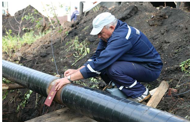
Дефектоскопист рентгено-гаммаграфирования группы рентгеновского контроля Иван Борцов проводит проверку сварочных швов стального газопровода, проложенного по улице Балаховской в г. Тамбове
