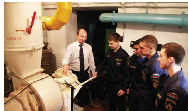
Главный энергетик Андрей Михалев знакомит с устройствами жизнеобеспечения защитного сооружения АО «Газпром газораспределение Тамбов»
