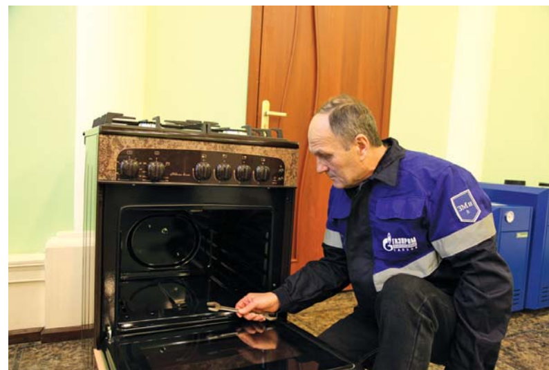
Слесарь по эксплуатации и ремонту газового оборудования СВДГО Евгений Пронин проводит техническое обслуживание газовой плиты
