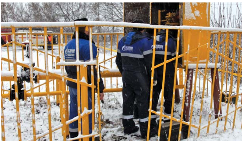
Слесари Александр Фомин, Юрий Разуваев, Дмитрий Редин, Алексей Жуков проводят работы по устранению неисправности ГШРП
