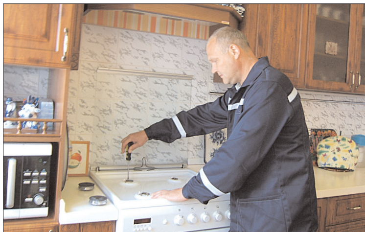
Слесарь ВДГО пятого разряда Вячеслав Зеленин выполняет техническое обслуживание импортной газовой плиты "Горение"
