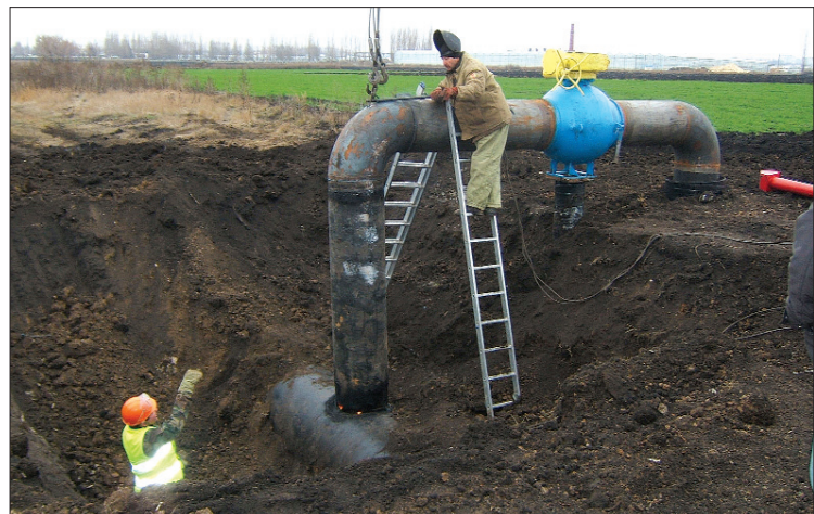
Работники службы подземных газопроводов осуществляют врезку на газопроводе высокого давления от ГРС 2 а
